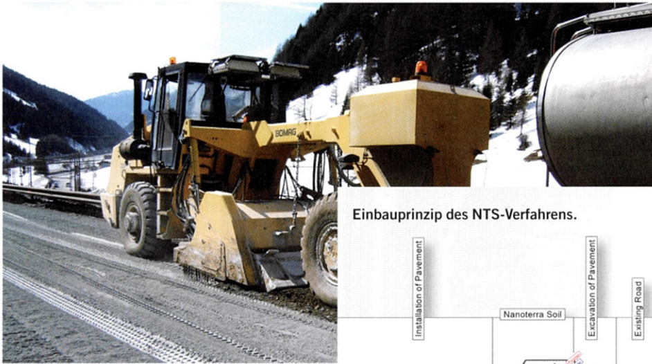
Auf dem im Jahr 2006 mit NTS-Technologie sanierten Teilstück der Brennerautobahn sind bisher noch keine Schäden aufgetreten. Foto und Abbildung: NanoSky
