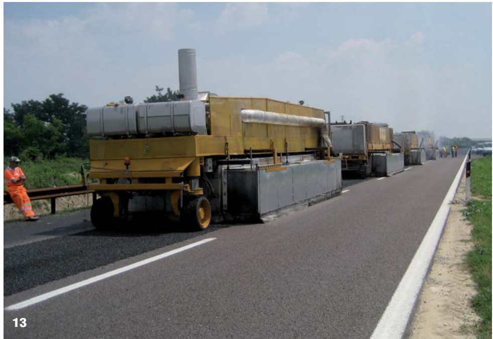
13. La tecnologia Pavirec all'opera
